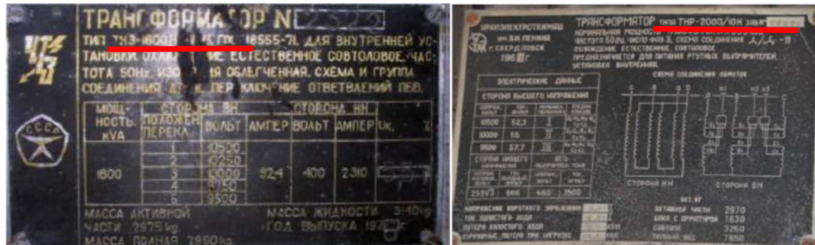
Рисунок 1: Заводская табличка российских ПХД трансформаторов
