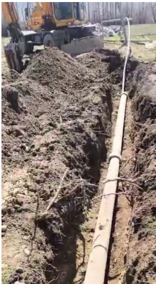
Укладка трубы (гильзы)
