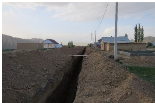
Фото 23 - 24. На траншеях установлены временные переходные мостики. Дороги села восстановлены (с. Кайынды-Булак, статус: май 2025 г.)
