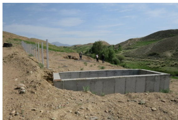
Фото 5 - 6. Каптажные камеры у родников. Площадка резервуара (с. Беш-Терек, статус: май 2025 г.)
