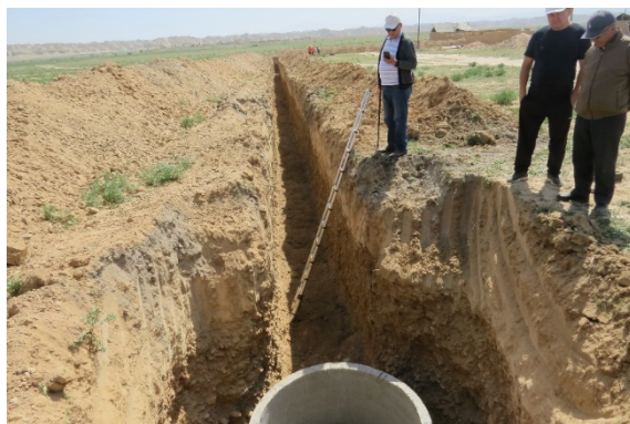
Фото 31. Установлены временные лестницы для строительно-монтажных работ (п/п «Баатов», статус: июнь 2025 г.)
