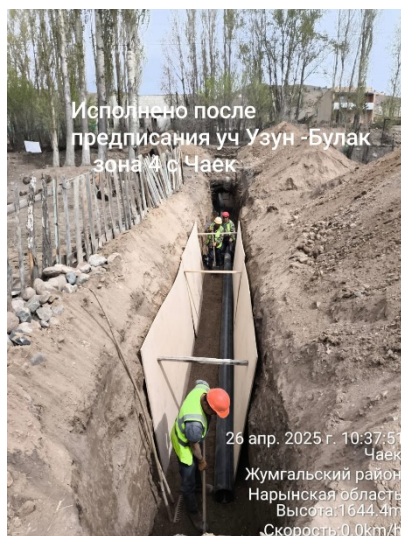
Фото 38. Траншеи укреплены защитными щитами и подпорками (подпроект Чаек, статус: на июнь 2025 г.)
