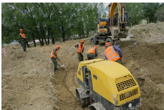
Фото 27 - 28. Трамбовка после укладки водовода. Баннер Подрядчика (с. Жерге-Тал, статус: май 2025 г.)
