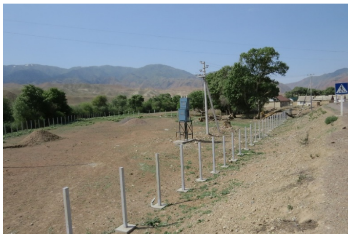
Фото 41. Установлены стойки для ограждения площадки водозабора (подпроект Арал, статус: на июнь 2025 г.)
