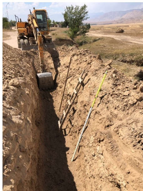
Фото 1 - 2. Строительство дороги до источника водоснабжения. Разработка траншеи водовода (с. Лама, статус: май 2025 г.)
