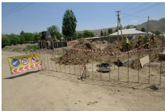
Фото 9 - 10. Установлены светоотражающие предупредительные знаки и ограждения на траншеях (с. Чаек (зона № 1), статус: май 2025 г.)
