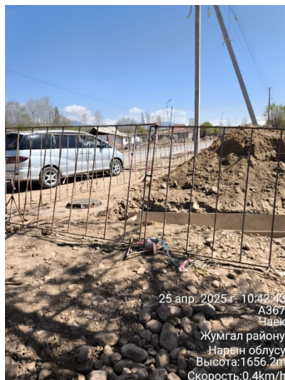
Фото 32. На траншеях установлены прочные защитные ограждения (п/п «Чаек», статус: июнь 2025 г.)
