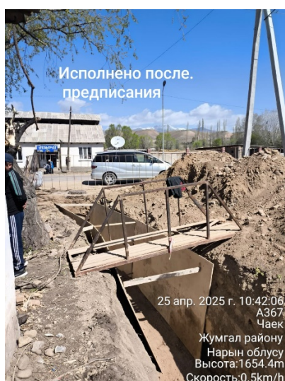
Фото 7 - 8. Разработка траншеи водовода (с. Чаек (зона № 4), статус: апрель 2025 г.).
