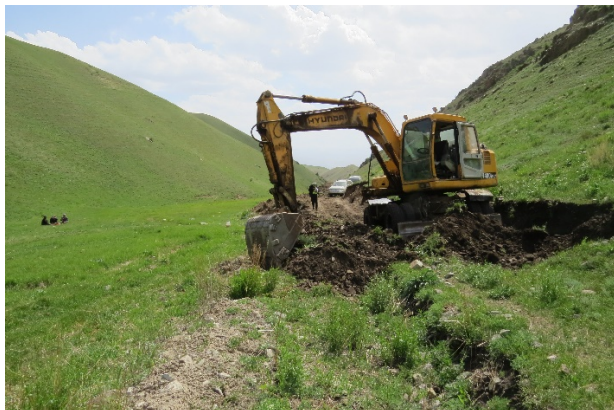
Фото 1 - 2. Строительство дороги до источника водоснабжения. Разработка траншеи водовода (с. Лама, статус: май 2025 г.)
