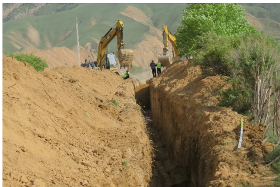
Фото 25 - 26. Укладка водовода из ПЭ труб. Осмотр источника водоснабжения (с. Куланак, статус: май 2025 г.)
