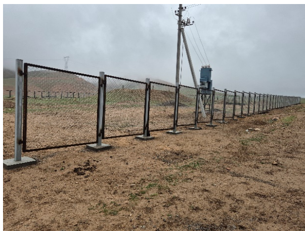
Фото 29: Площадка резервуара полностью огорожен (подпроект Лама, статус: на июнь 2025 г.)
