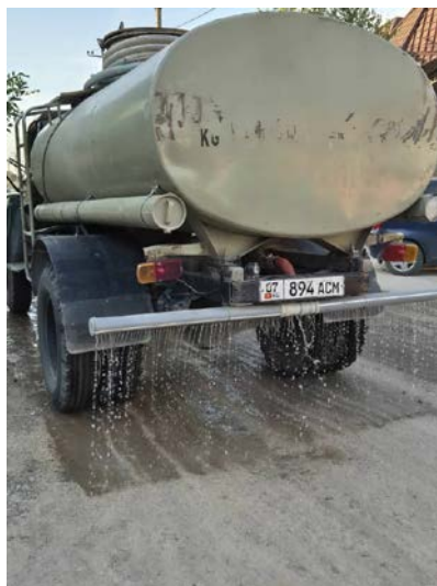
Фото 45. Пылоподавления улиц села после обратной засыпки траншеи (с. Чаек зона № 1, статус: июнь 2025)
