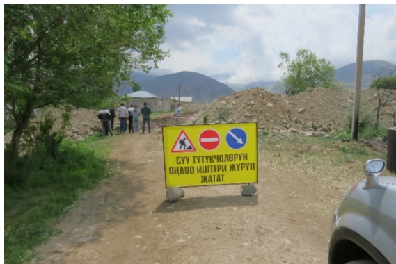
Фото 30. Установлены предупредительные знаки (подпроект «Исакеев», статус: июнь 2025 г.)
