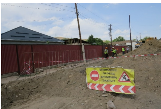
Фото 9 - 10. Установлены светоотражающие предупредительные знаки и ограждения на траншеях (с. Чаек (зона № 1), статус: май 2025 г.)
