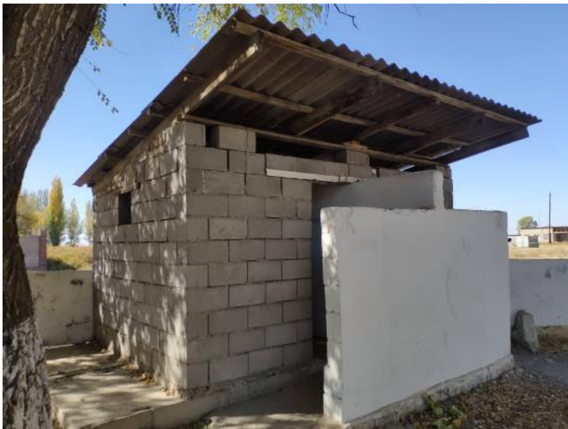
Рис 2. Помещение под строительство внутреннего санузла
