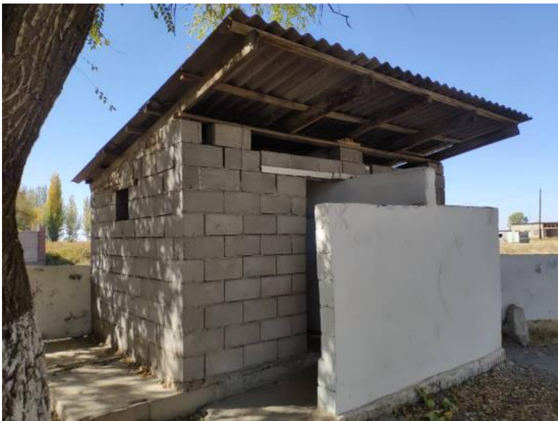
Рис 2. Помещение под строительство внутреннего санузла
