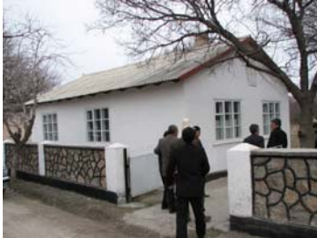
Отремонтированное здание ФАП в селе Актатыр
