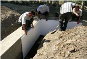
Для теплоизоляции фундаментов используется полистирольный пенопласт
