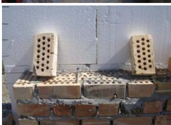
Теплоизоляция стен производится параллельно с их возведением
