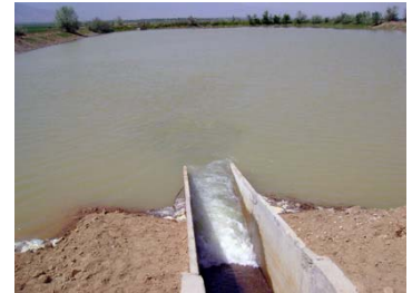
Бассейн суточного регулирования в с. Туйто Бакай-Атинского района Таласской области
