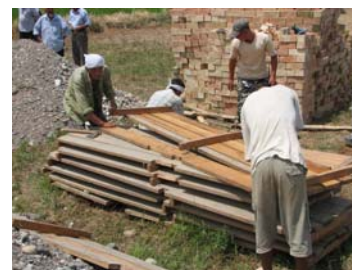
Строительство малогабаритного энергоэффективного здания ФАП в селе Сейдикум Базаркоргонского района Жалалабатской области
