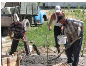
Начало строительства одного из пилотных проектов по инновационным технологиям
