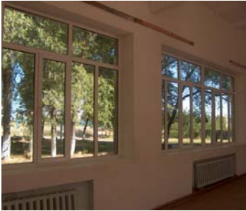
Отремонтированное помещение в одной из школ Аламудунского района Чуйской области
