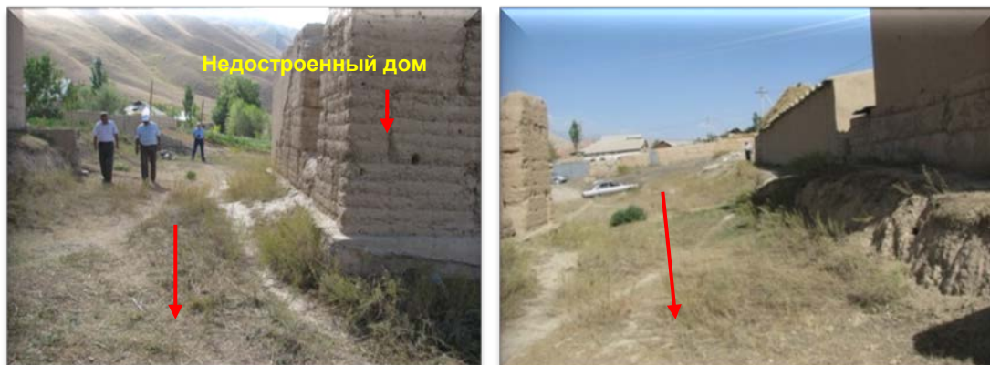
Фото 5-6. Земельный участок с недостроенным домом, по которому планируется прокладка водораспределительной сети (1 фото - вид с востока на запад; 2 фото - вид с запада на восток)
