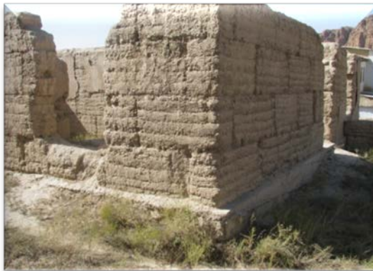
Фото 8. Недостроенное строение на территории участка № 172 по ул. Аско-Тоо
