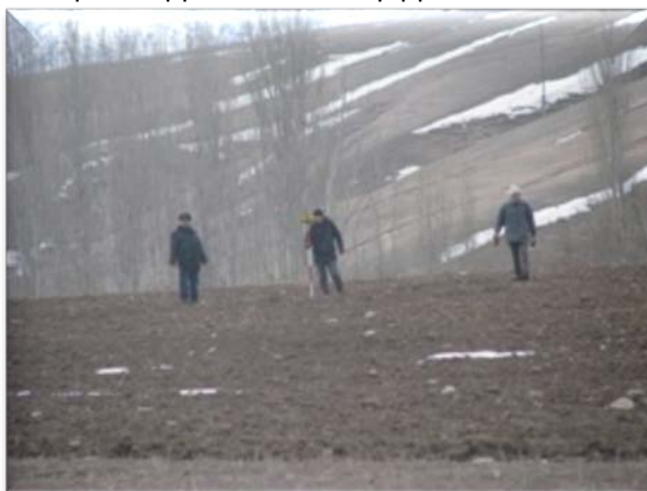
Фото 7. Вынос проекта РЧВ в натуру
