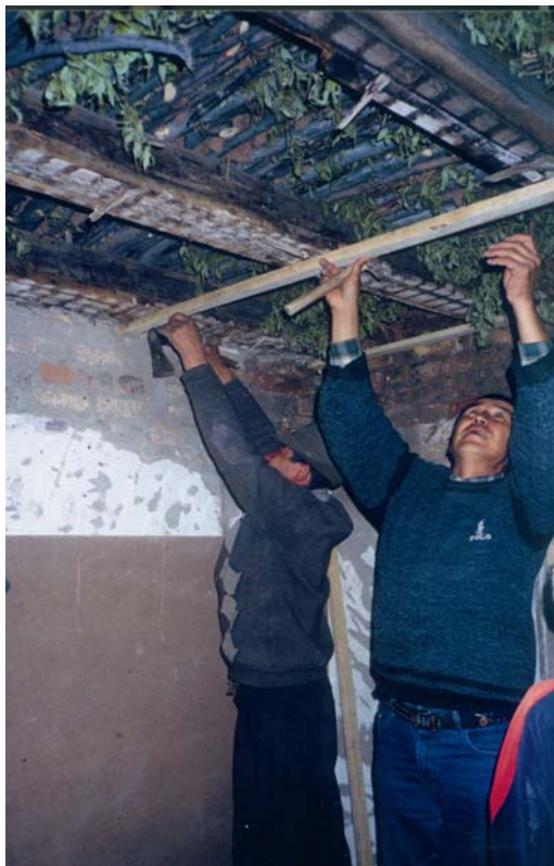
Местными жителями ведутся строительные работы по ремонту ФАП
