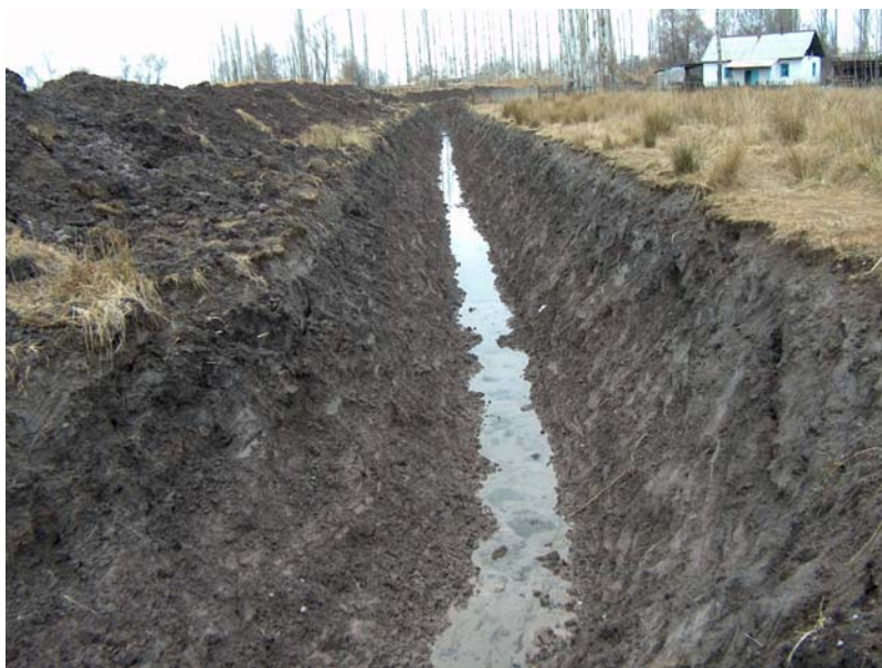
Частичная механизированная очистка коллекторно-дренажной сети села Кош-Дебе
