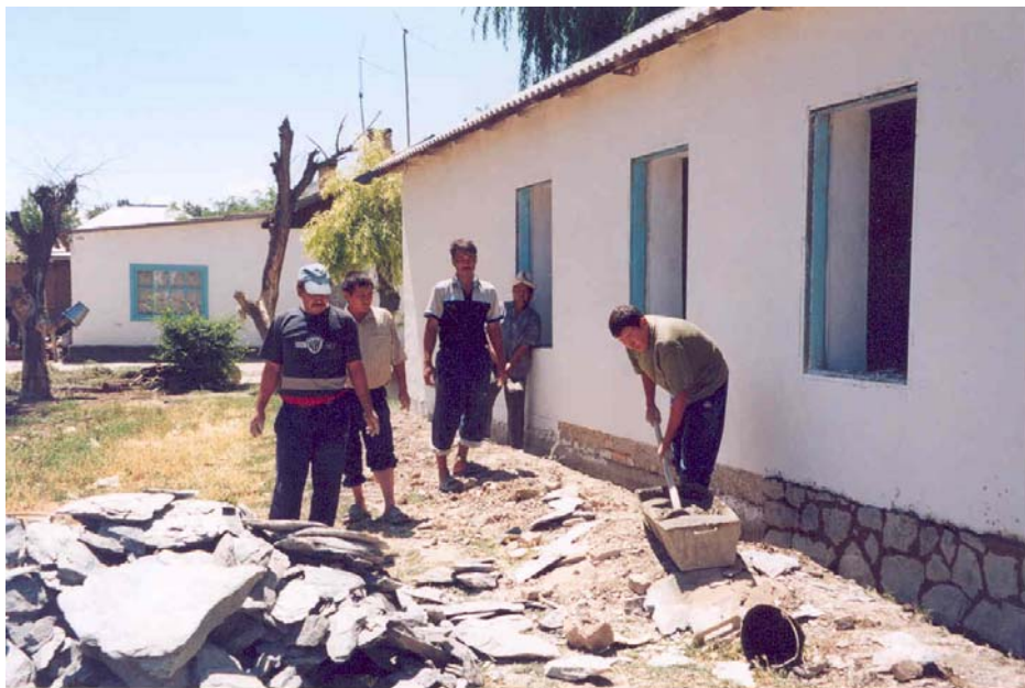
Силами местного сообщества ведется ремонт здания начальных классов.
